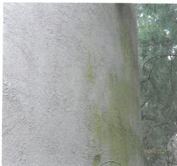
Fot. nr 11 Elewacja – widoczne glony
